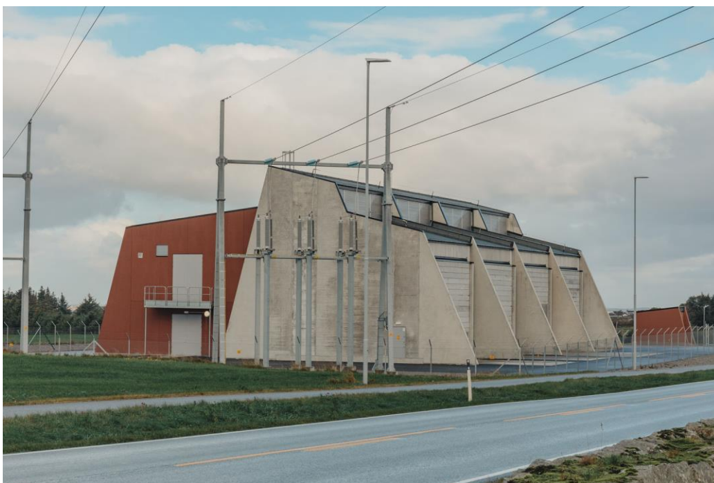
Nye Opstad transformatorstasjon. Foto: Johannes W Berg
